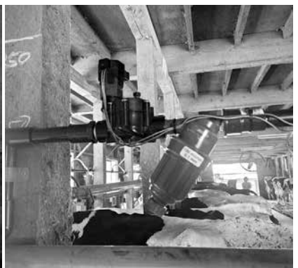
【コントローラーと電磁弁(噴射する頻度を調整できる)】
