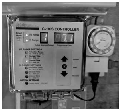
【コントローラーと電磁弁(噴射する頻度を調整できる)】
